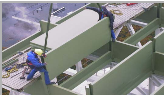
Całkowicie gładkie ściany, montaż systemu silosów bez użycia śrub.
