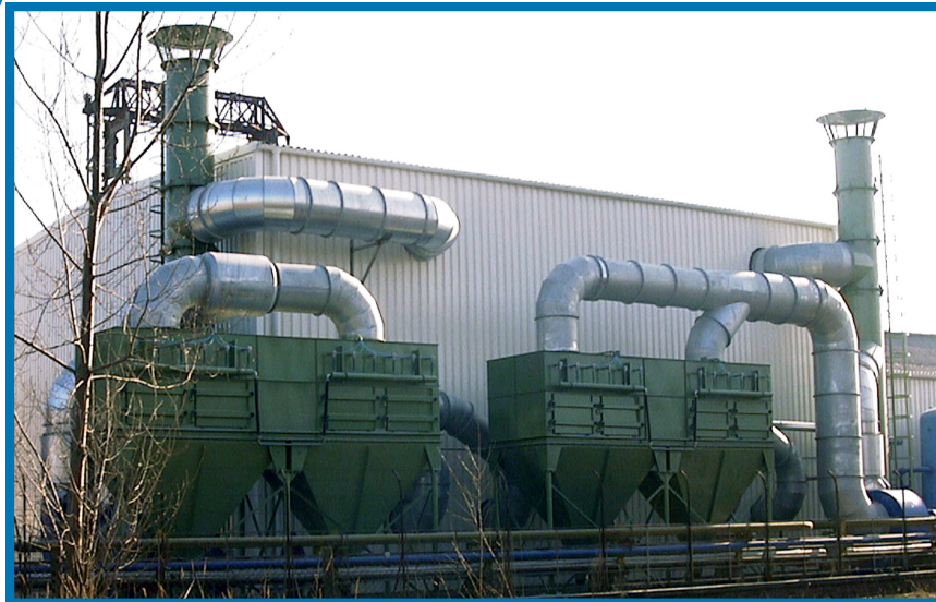
Tigép Ltd. Tiszakécske - Blasting hall, 2 x 60.000 m 3 /h aspiration system
